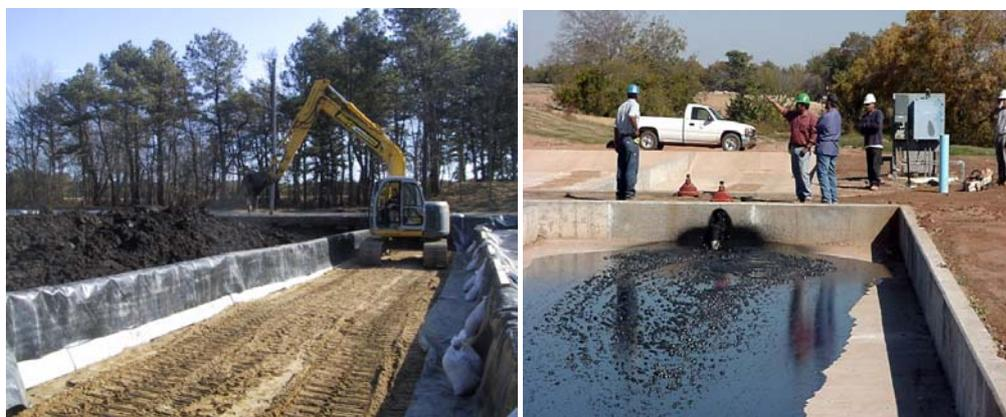
Les lits de séchage ne sont pas particulièrement adaptés pour les boues mazoutées car le séchage et le drainage sont lents et le drain peut se retrouver bouche par du pétrole.
