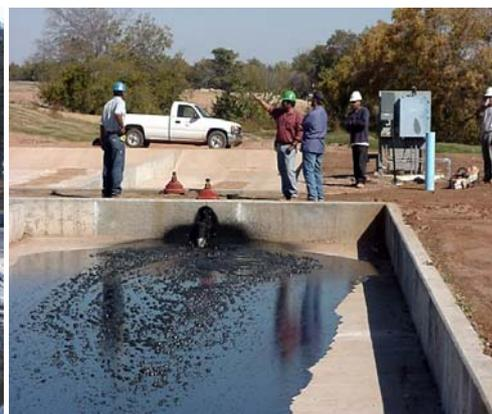
Les lits de séchage ne sont pas particulièrement adaptés pour les boues contenant des hydrocarbures car le séchage et le drainage sont lents et le drain peut se retrouver bouché par du pétrole.
