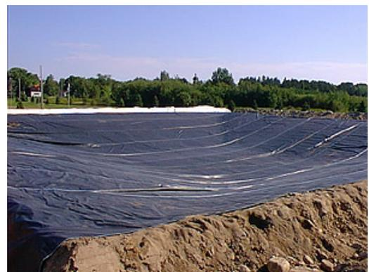
L'extraction d'eau est le résultat de la séparation physique selon le poids spécifique et l'évaporation des liquides (au cours d'une période plus longue). La suppression des liquides libres du bassin peut être réalisée facilement en pompant par la surface tandis que les sédiments peuvent être supprimés par creusement ou dragage. Le nettoyage des bassins à intervalle régulier (suppression des sédiments) est nécessaire.
