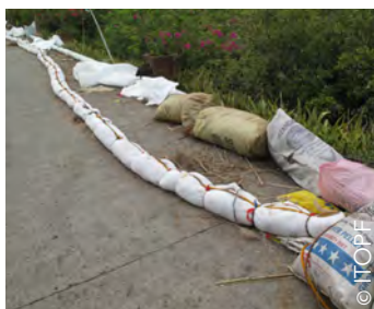
Barrage à façon avec du foin
