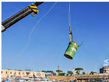
Relevage d'un fût à l'aide d'une grue
